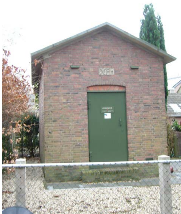
Beek, trafohuisje aan de Elzenweg. Type K2, toegepast tussen 1950 en 1962. Kenmerken van wederopbouwarchitectuur: siermetselwerk in ontlastingsboog boven deur, PGEM bouwkeramiek, kleurig metselwerk in Noors- of kettingverband. Foto P. Coenen.
