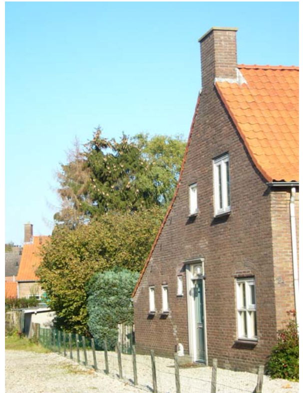
Beek, Bongerstraat, oneven zijde. Arbeiderswoning uit de eerste lichting na de oorlog, 1946. Gemeentearchitect J.A.J. van den Boogaard.
